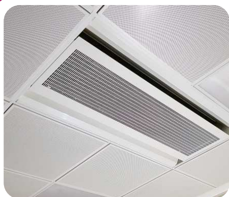
VAK instalação no teto
