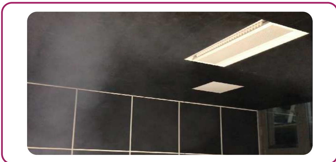
Exemplos de difusão em diferentes direções
