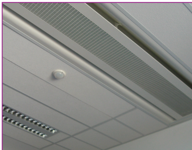
Instalación Viga Fría VFK 600
