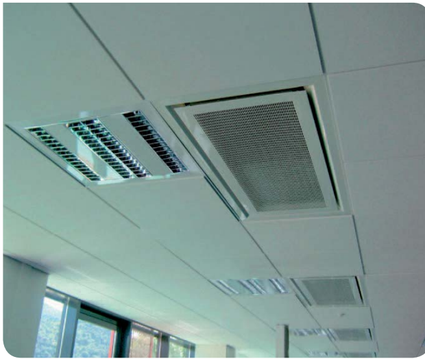
Deckeninduktionsauslass
