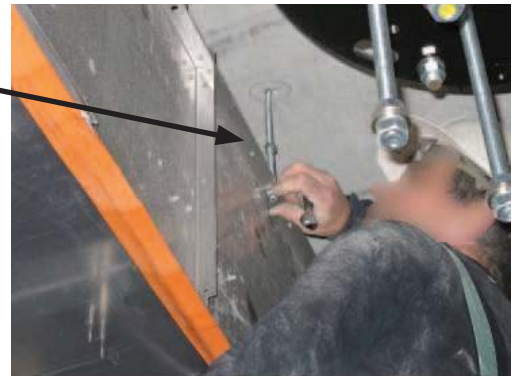
Fijar con arandelas y tuercas
