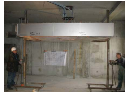
3 - Elevar el panel de forma simultanea hasta su ubicación, asegurándose de que se introduzcan correctamente las varillas en los puntos de anclaje
