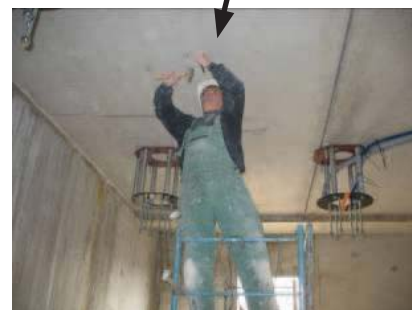
2. Colocar taco de anclaje
