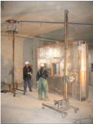
1 - Preposicionar el panel en su ubicación
