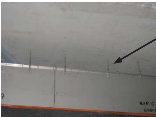
Fijar con arandelas y tuercas
